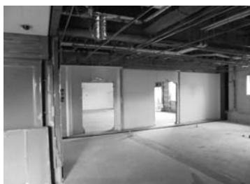
▲既存棟の一部を解体した様子。これから新たに内装を施工します。
