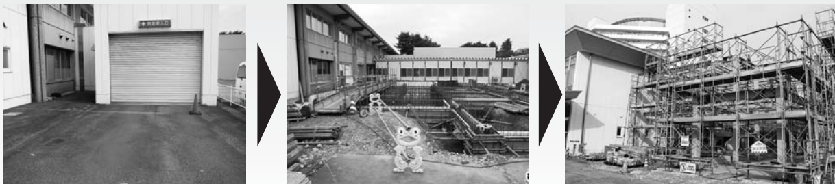
▲かつての救急車車庫を解体し、増築棟を建設しています。
